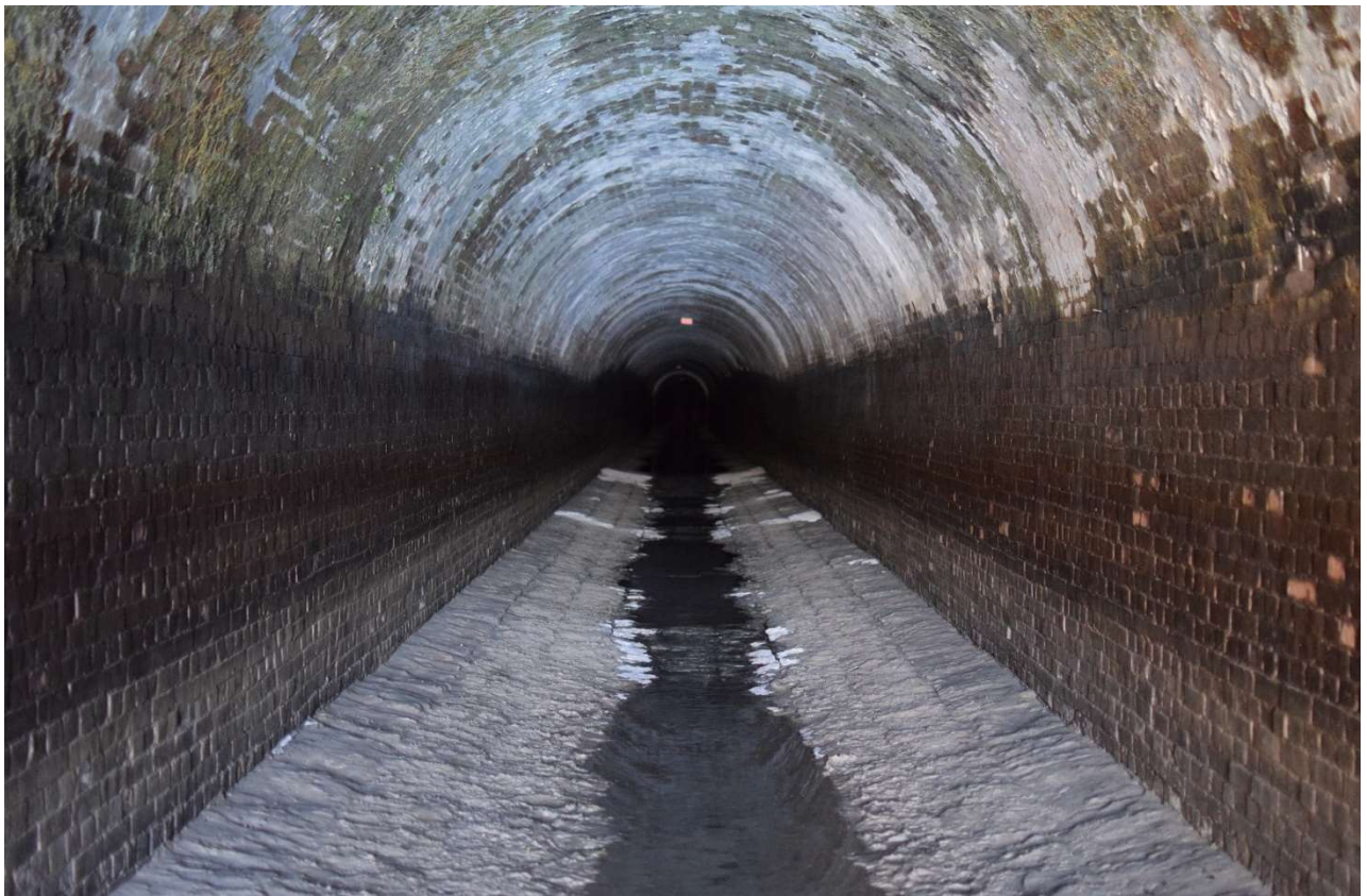
取入口隧道 水路中間部
