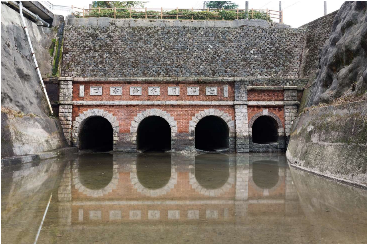
取入口隧道 出口
