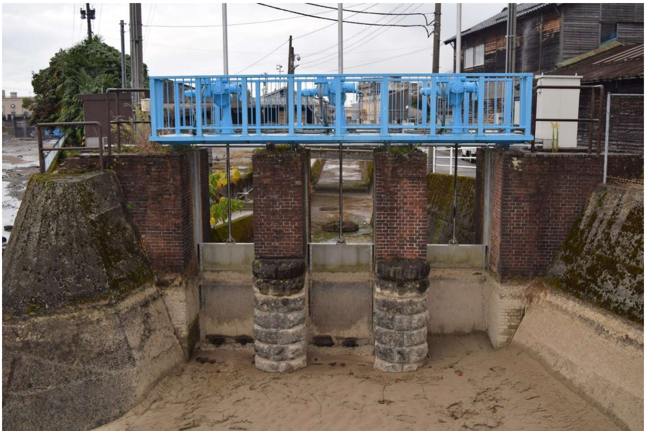
富樫用水取入口水門
