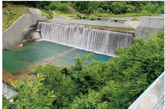
図2 手取川本流の砂防堰堤
