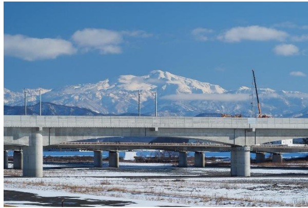
手取川橋りょうと白山（川北町）
