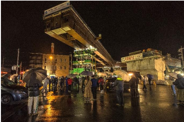
北浅井交差点の架橋工事（小松市）
