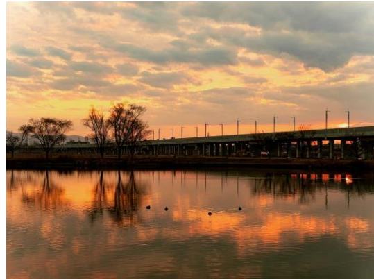
木場潟北公園からの高架橋（小松市）
