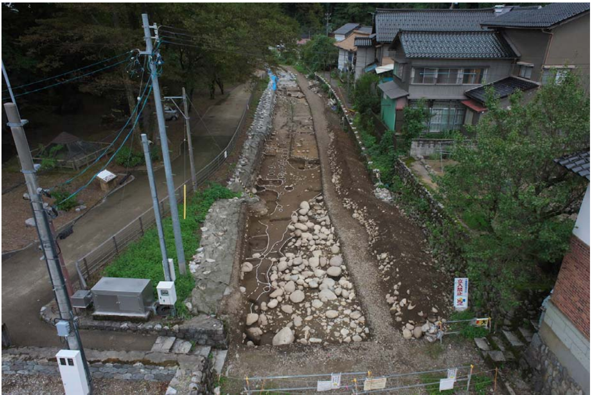
古宮遺跡 調査地の全景 (南東から)
