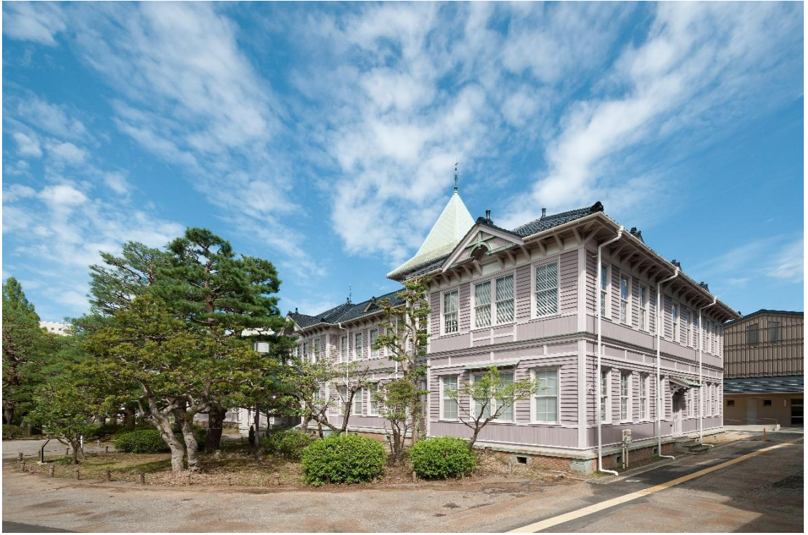
正面外観（南から）
