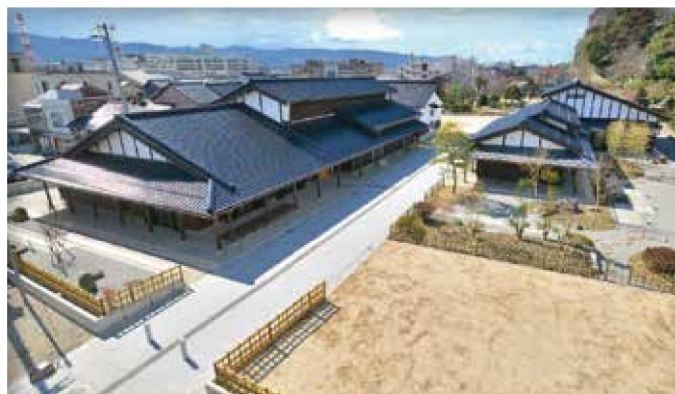
第23回いしかわ景観賞 七尾市中心市街地観光交流センター (花嫁のれん館・寄合い処みそぎ)
