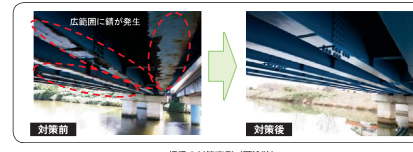
橋梁の対策事例(再塗装)
