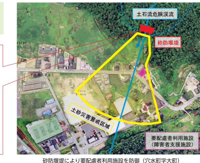
砂防堰堤により要配慮者利用施設を防御(穴水町宇大町)
