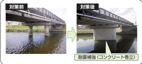
橋梁耐震補強
