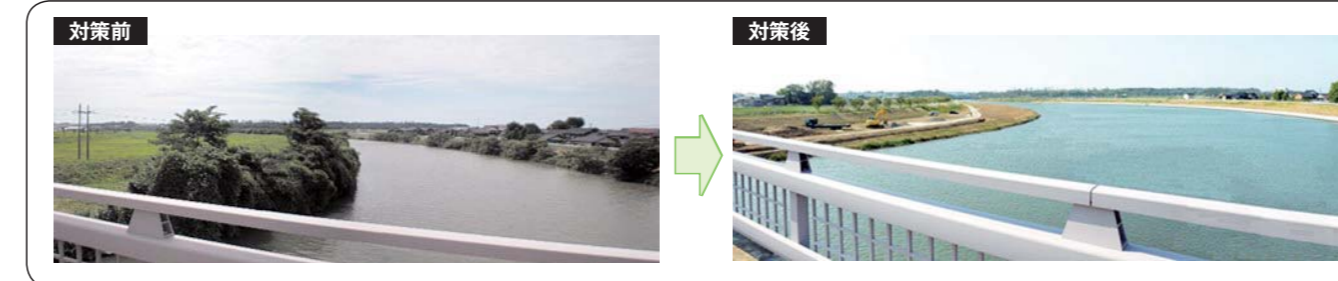
河川の拡幅による河川改修(犀川)
