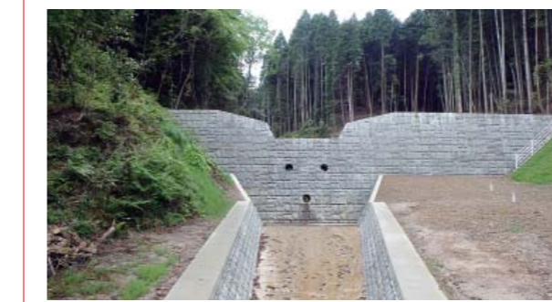
整備した砂防堰堤
