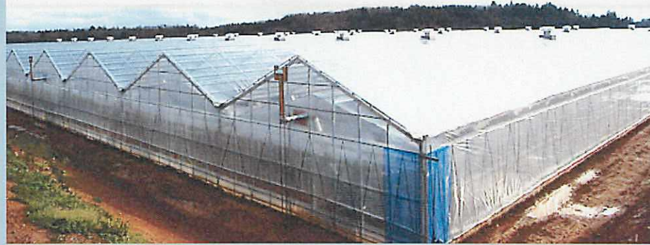
ベビーリーフを栽培するビニールハウス(12連棟)
