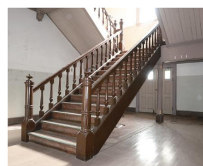
ケヤキ造りの重厚な階段 (移築前の旧第九師団司令部庁舎)
