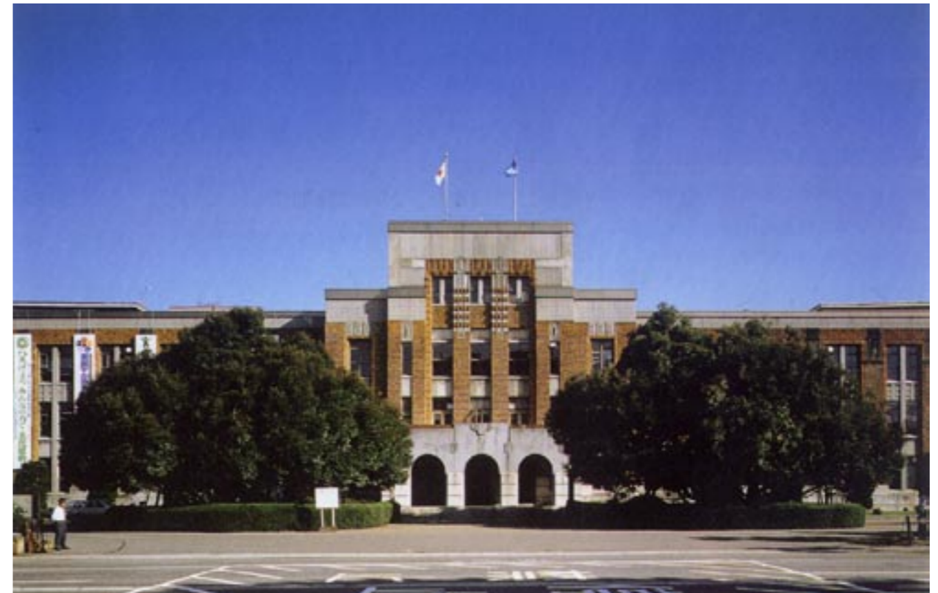
● 「堂形のシイノキ」と一体の景観を形成する旧県庁舎正面
