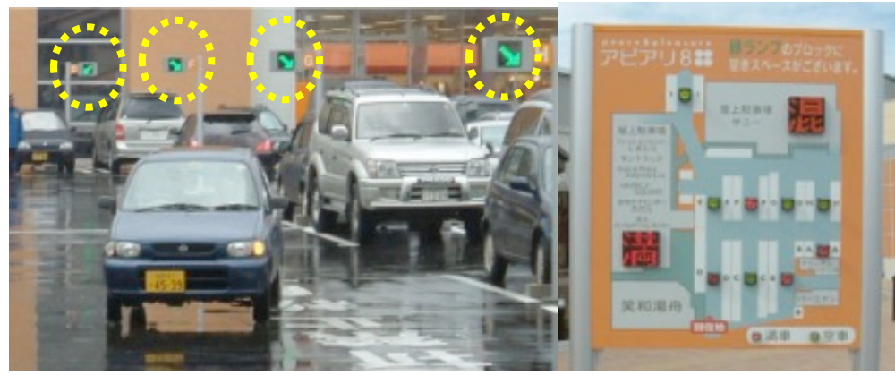
駐車場誘導システム 屋外誘導灯、駐車場満空表示盤等
