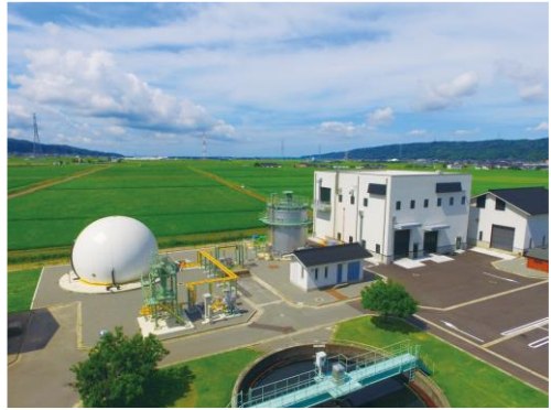
中能登町 鹿島中部クリーンセンター
