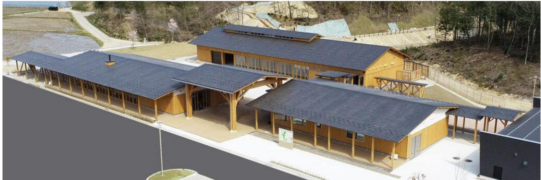
CLTを活用した里山交流ハウス（木場湯公園東園地）
