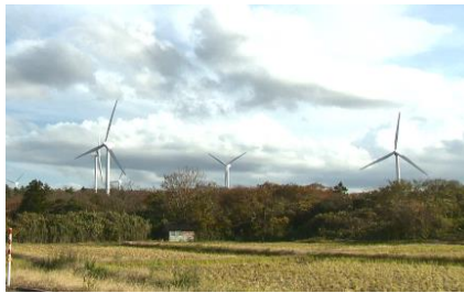
風力発電（福浦風力発電所）
