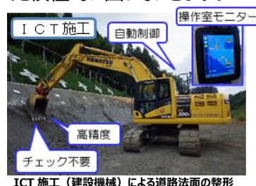
ICT施工（建設機械）による道路法面の整形
