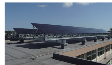
公共设施的屋顶安装太阳能发电设施
