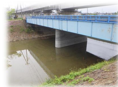
橋梁耐震化（巻立て補強） （森下川橋）
