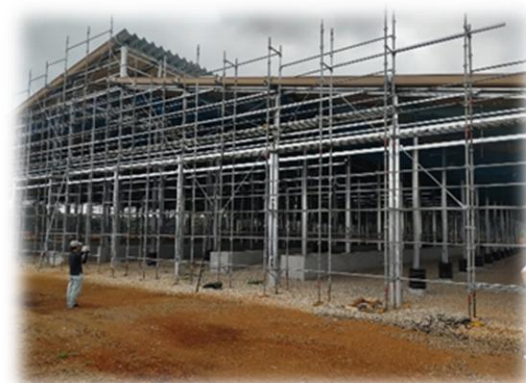
建設中の畜舎
