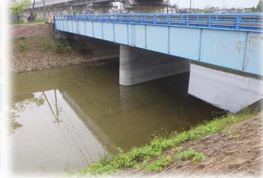
橋梁耐震化（森下川橋）
