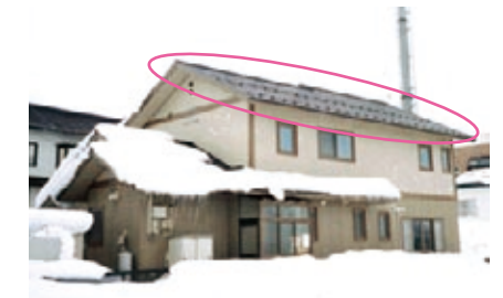
屋根融雪装置の稼働状況
