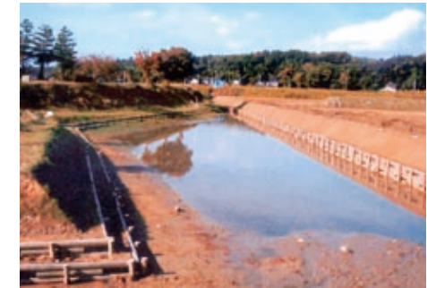
木柵による水路整備
