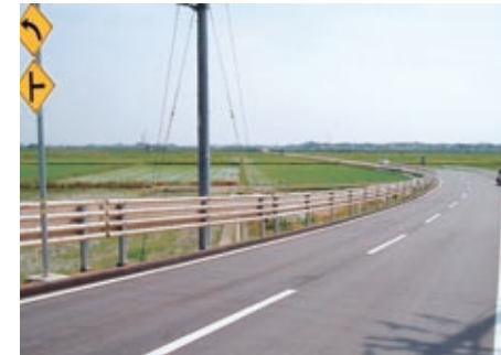
生態系に配慮した農道整備 【野鳥生息地に配慮して遮光板(間伐材)を設置】
