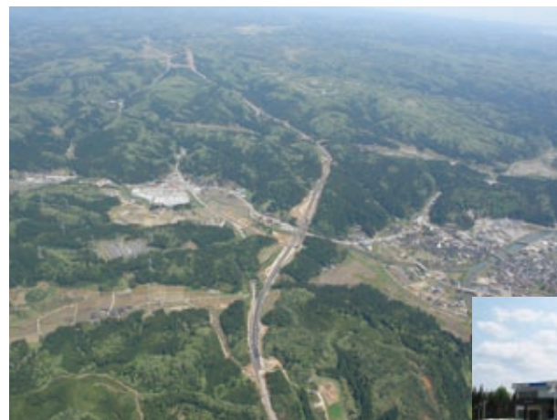
能越自動車道穴水道路
