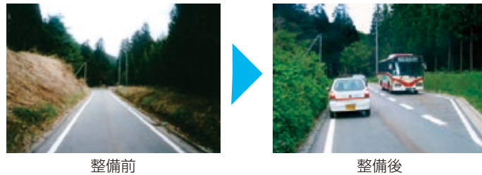
【1.5車線の道路整備】
