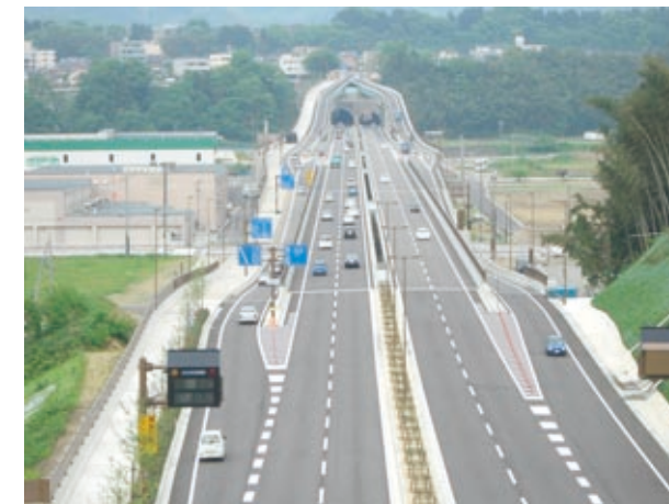
金沢外環状道路(山側環状) 野田町付近
