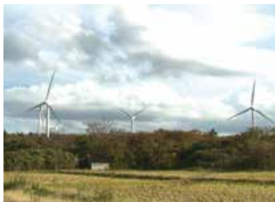
風力発電（福浦風力発電所）
