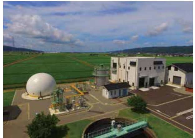
中能登町鹿島中部クリーンセンター
