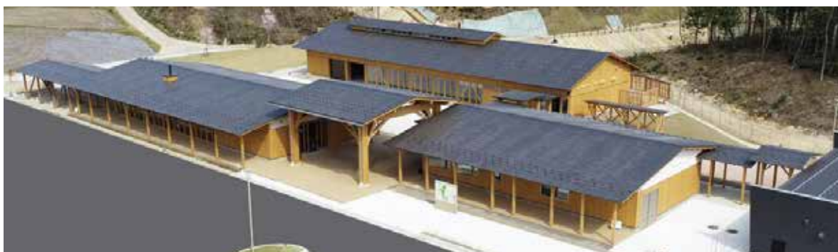
CLTを活用した里山交流ハウス（木場潟公園東園地）
