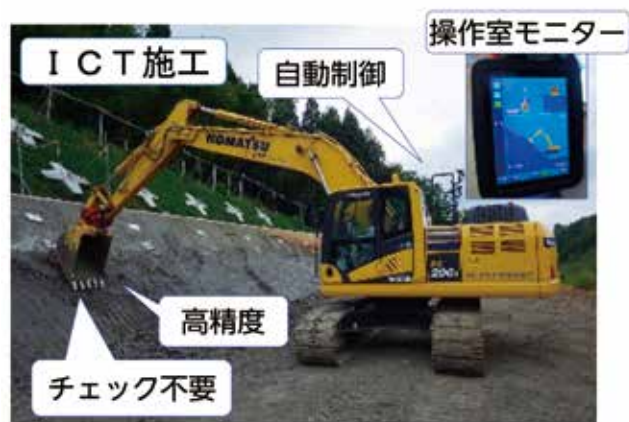
ICT施工（建設機械）による道路法面の整形
