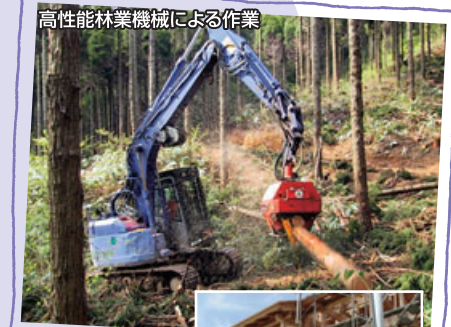
高性能林業機械による作業
