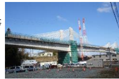
北陸新幹線延伸工事
