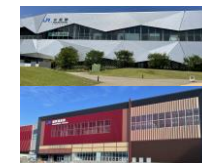
北陸新幹線駅舎整備 提供: JRTT鉄道・運輸機構
