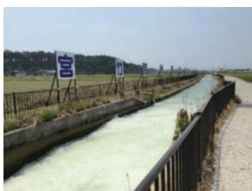
宮竹用水第二発電所
