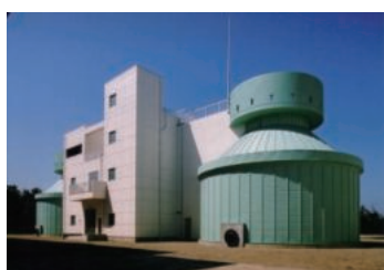
メタン発酵設備
