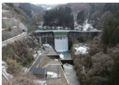
平沢川砂防堰堤
