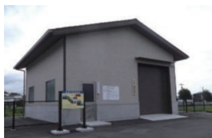
加賀三湖発電所
