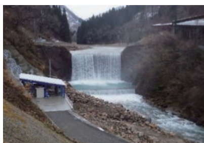
直海谷川 1 号砂防堰堤
