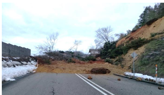
<道路寸断(珠洲道路)>
