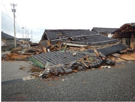
< 旧角海家住宅(輪島市)の被害 >
