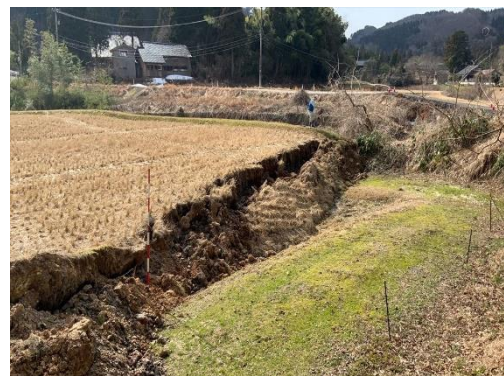
<農地の地割れ(珠洲市若山町中)>
