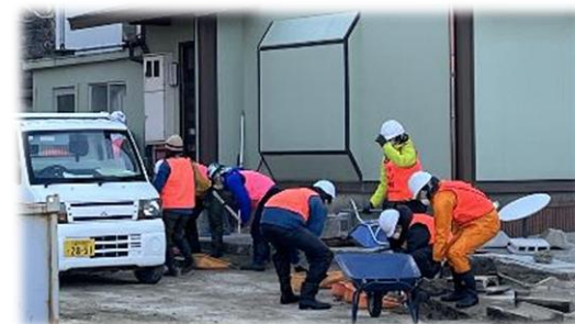
復旧作業のお手伝い
