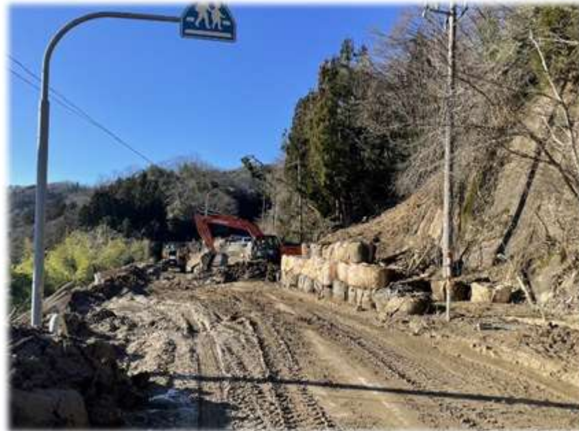
県道の復旧作業状況（輪島市内）
