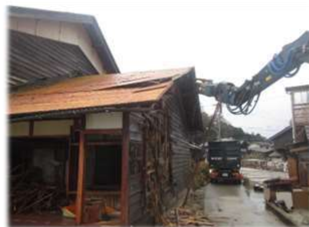
公費解体の様子
