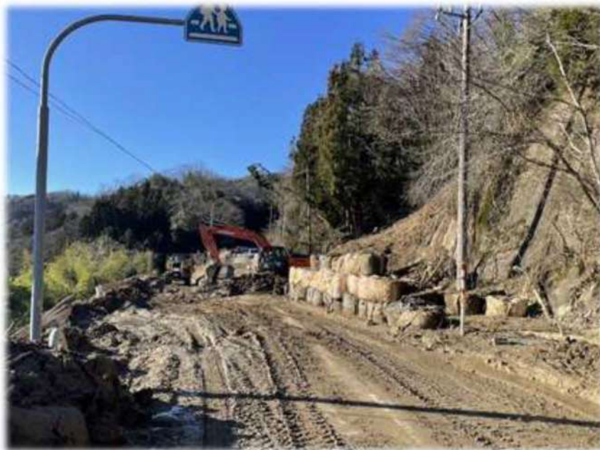
県道の復旧作業状況（輪島市内）
