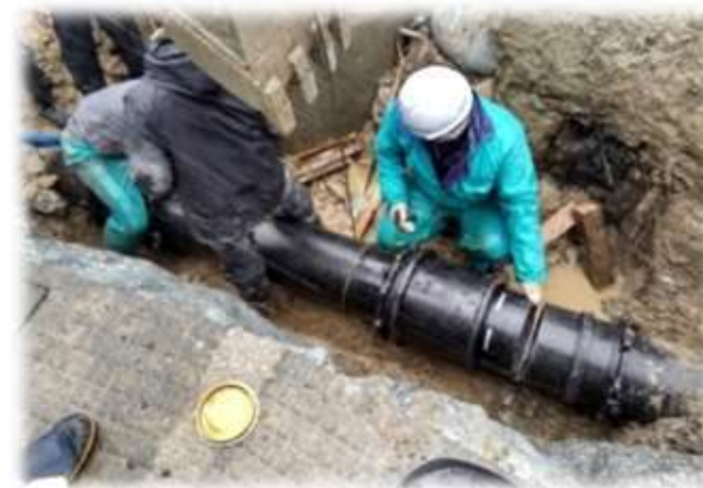
水道管の復旧作業状況（輪島市）
