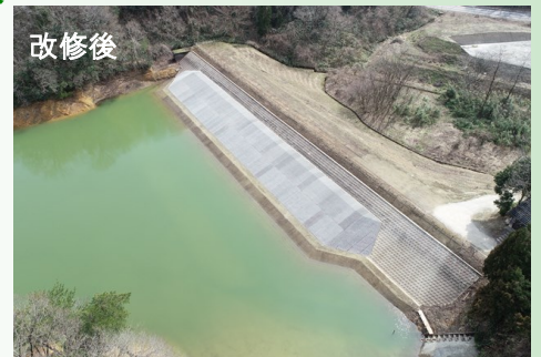
県営震災対策農業施設整備事業 津幡大池地区 (河北郡津幡町宇津幡)
