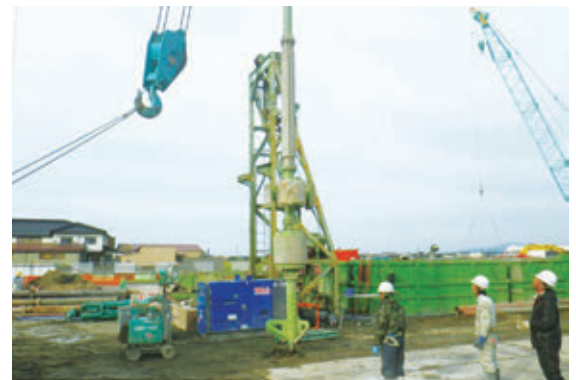
掘削機械（回転ビットとドリルパイプ）
