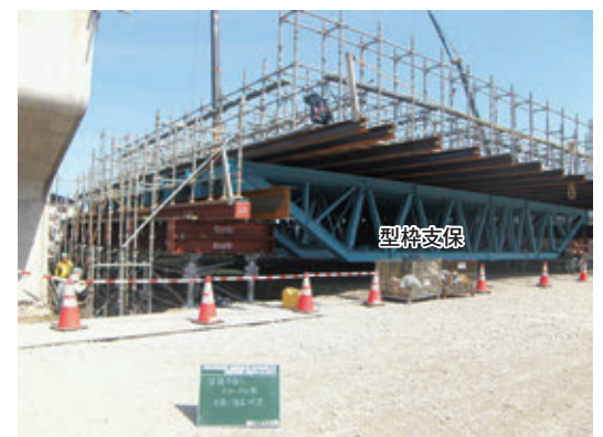
型枠支保工の組立
