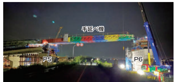
送り出し(手延べ機が橋脚に到達する直前)の状況
