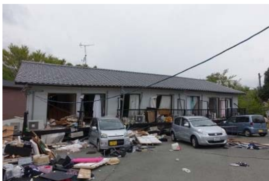
写真 12 倒壊した木造アパート
