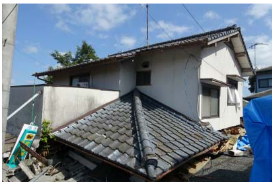
写真2 倒壊した木造住宅
