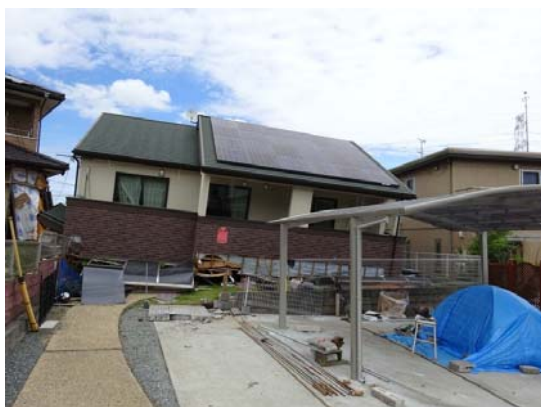
写真4 倒壊した木造住宅
