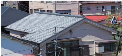
健全な瓦屋根
