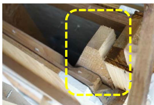
写真 13 写真 12 のアパートの筋かい端部 (釘打ちによる接合)
