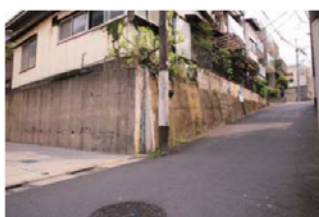
擁壁や坂 に面する
