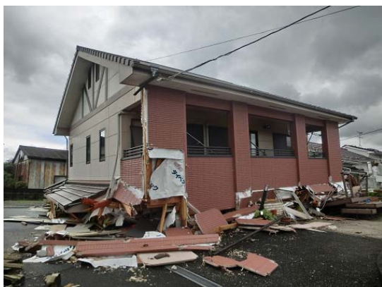
写真6 倒壊した木造住宅
