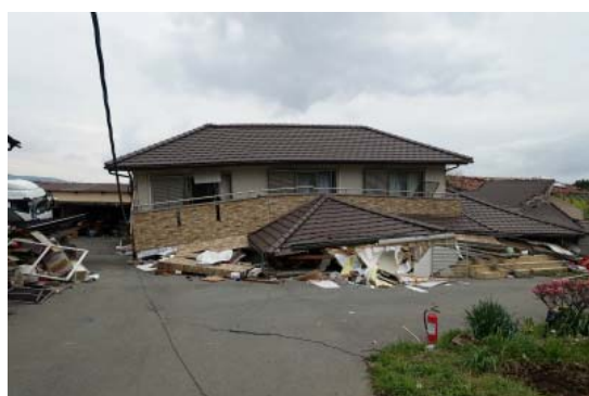
写真 16 倒壊した木造住宅
