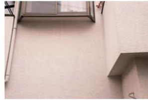
健全な外壁（ひび割れ等がない）
