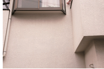
健全な外壁（ひび割れ等がない）
