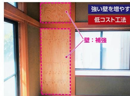
Point 真壁(和室によく用いられる壁)は天井や床に加えて、壁も壊さずに補強することが可能
