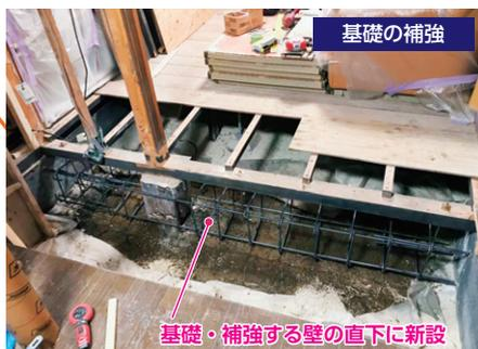
**Point** 基礎の補強は部分的に実施し、必要最低限とする
