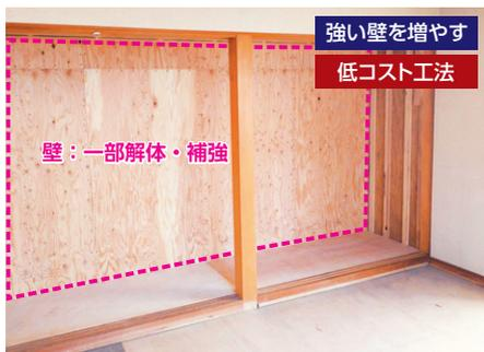
**Point** 仕上の復旧が簡便な押入は積極的に補強する
