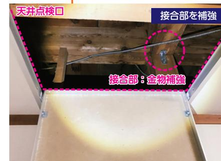
Point 天井点検口を設けて、柱と梁の接合部を金物で補強する
