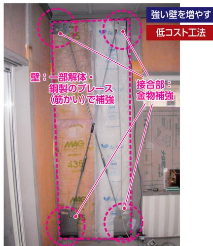
**Point** 接合部補強を兼ねた鋼製のブレースで補強する
