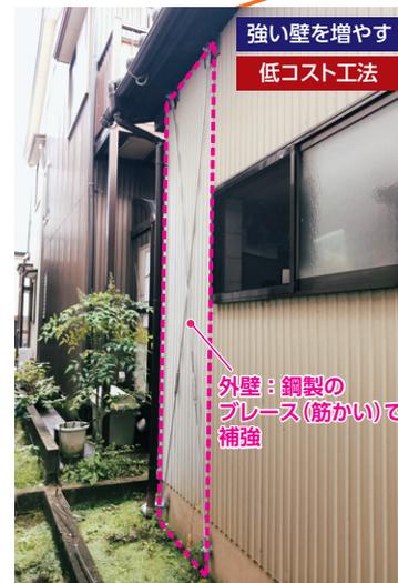
Point 外部から補強し、壁や窓を壊さずに補強する
