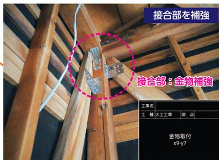
Point 柱や筋かいを金物で補強し、地震で外れないようにする
