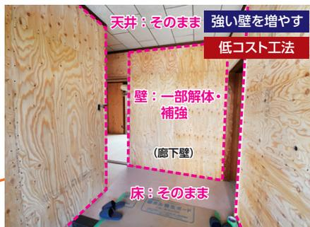
Point 低コスト工法で天井や床を壊さずに、構造用合板による強い壁をつくる
