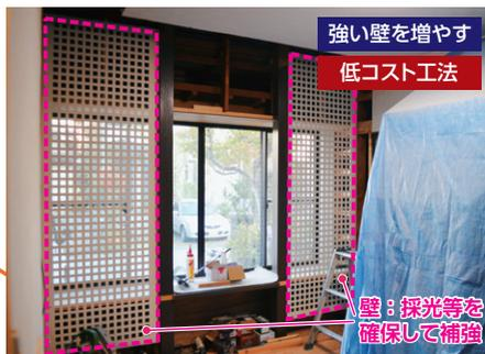
**Point** 通風や採光を確保した耐力壁による補強を実現する
