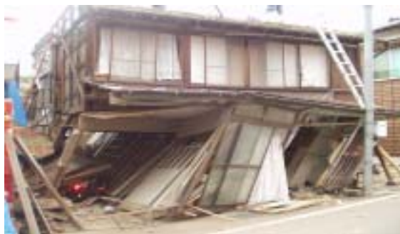
図 4-2 住宅の被害（穴水町大町）
