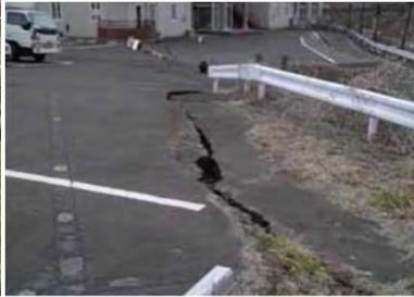
(b)のり尻の亀裂の事例
