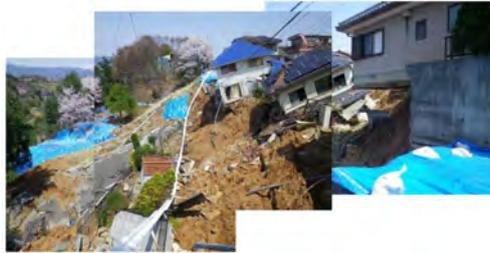
(d)液状化による側方流動の事例
