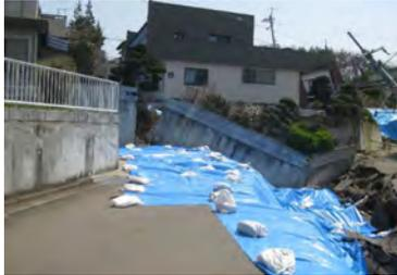
(c)腹付け盛土の崩壊の事例
