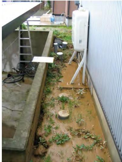
>破裂して水が流出している 41
