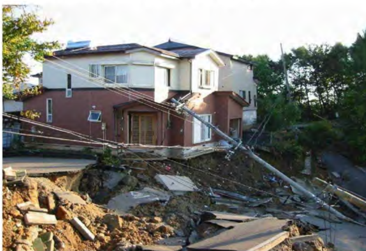
2016新潟県中越地震の被害
