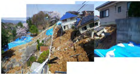
(d)液状化による側方流動の事例
