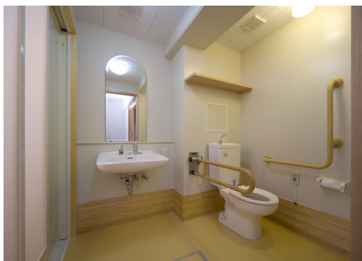
図 県営住宅のバリアフリー化状況(左：障害者用住戸便所、右：玄関スロープ)
