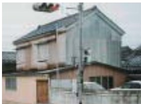
古民家を改修し集会所として活用した事例
