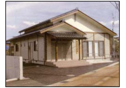
集会所等の耐震改修
