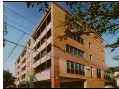
居住ニーズに応じた 高齢者居住施設の建設
