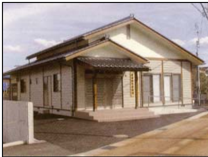
集会所等の耐震改修
