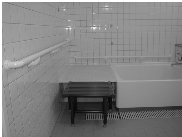
連続した手すりのある浴室
