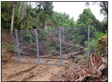
砂防の応急対策 (輪島市東印内町地内)
