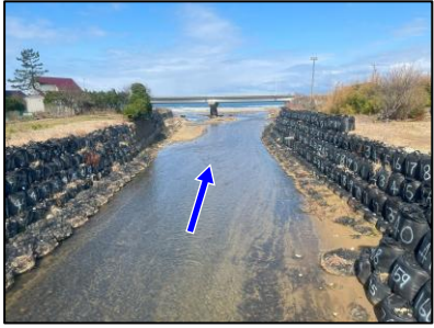
河川の応急対策 (輪島市小田屋町地内)
