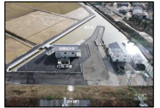
⑥護岸復旧 R6完了 (津幡町字下河合 地内)
