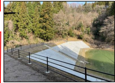
ため池整備 R7完了 (かほく市上山田 地内)
