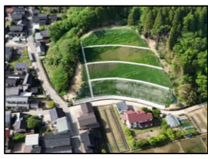
③護岸復旧 R6完了 (津幡町字津幡 地内)
