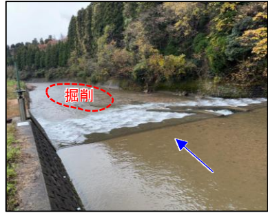
河川の堆積土砂除去 R6完了 (かほく市八野 地内)
