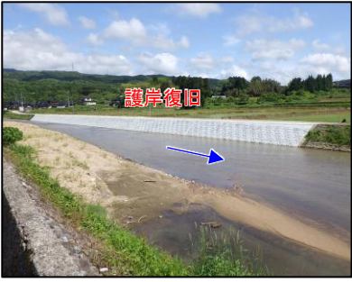
河川の堆積土砂除去 R5～施工中 (かほく市内高松 地内)
