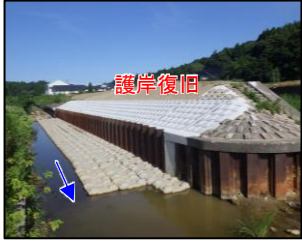
②がけ崩れ対策 R6完了 (津幡町字舟橋 地内)
