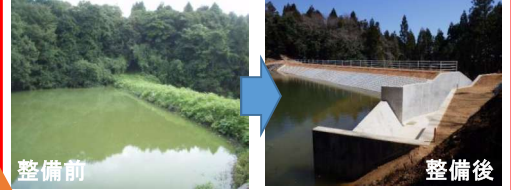
整備されたため池
