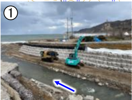
応急復旧状況
