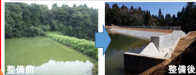
整備されたため池
