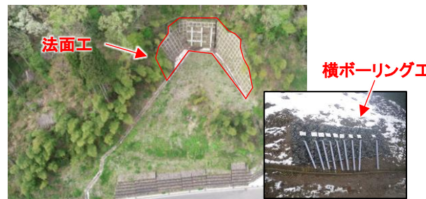
法面工や横ボーリング工による土砂移動抑制
