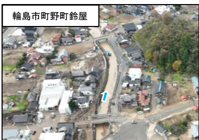
土砂流出による氾濫
