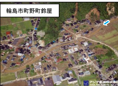
土砂流出による氾濫
