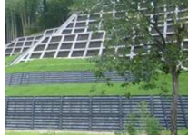
法枠工・土留工の整備
