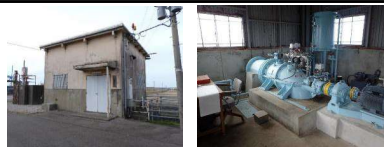
排水機のオーバーホール
