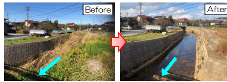
堆積土砂除去の事例
