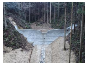
砂防堰堤・治山ダムの整備・保全
