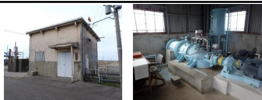
排水機のオーバーホール
