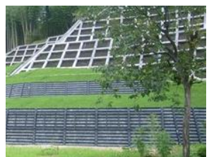
法枠工・土留工の整備
