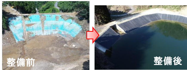
整備されたため池
