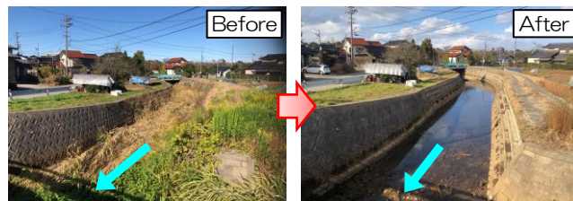
堆積土砂除去の事例
