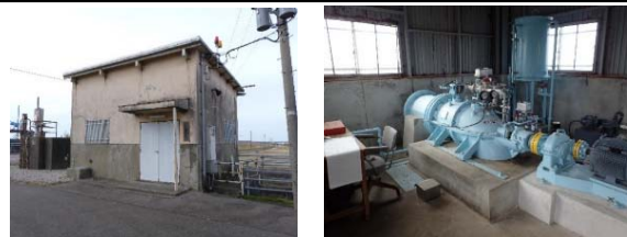
排水機のオーバーホール
