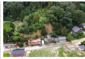
山腹崩壊地・がけ崩れ
