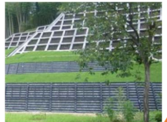
法枠工・土留工の整備
