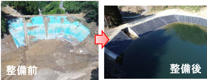
整備されたため池
