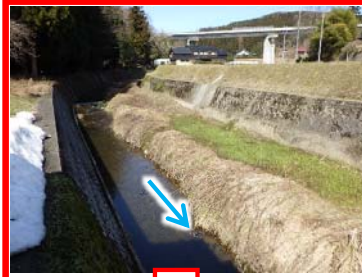
鈴内川における浚渫工事の実施（珠洲市）
