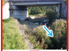
寺分川における浚渫工事の実施（能登町）
