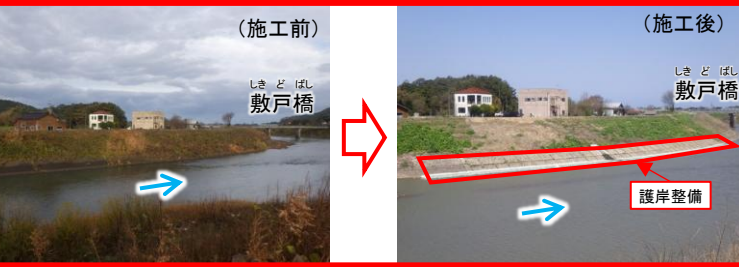
町野川における河川改修の実施（石川県）
