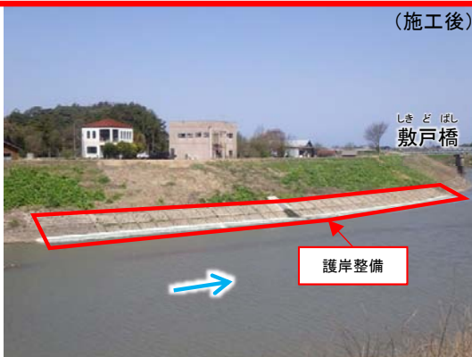
町野川における河川改修の実施（石川県）
